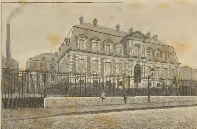
Fig. 2. - Vista de conjunto del Instituto Pasteur (De fotografía)
